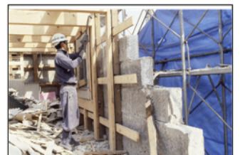
図4. 諏訪質店石蔵の解体 (小樽市花園)
