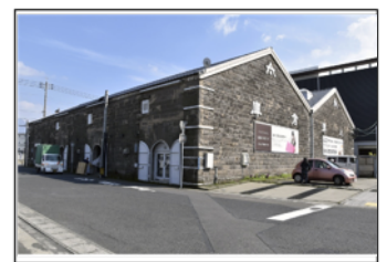
図8. 鹿児島市の旧大津倉庫
